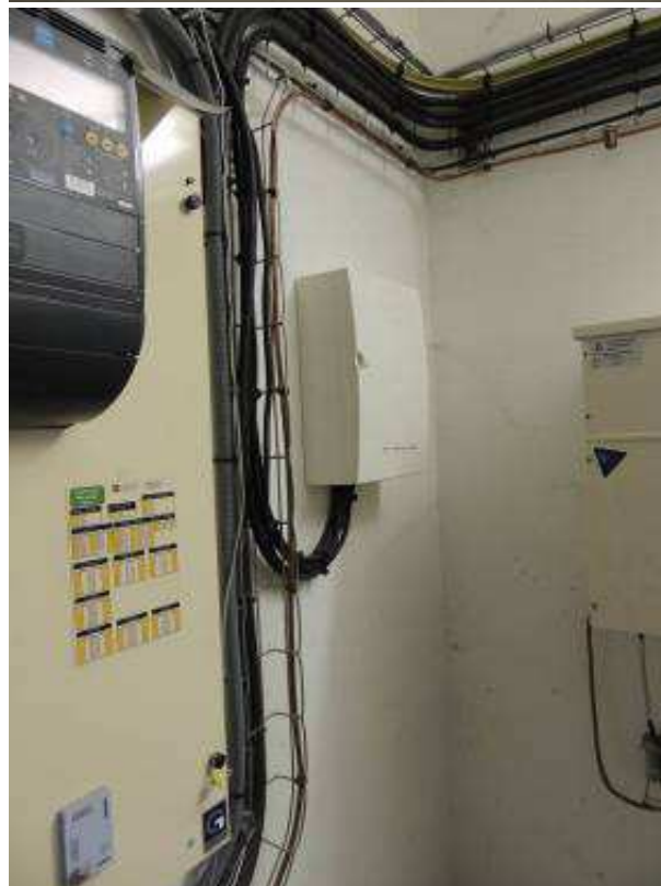
Chargeur 48V et coffret alimentation - ENSIACET
